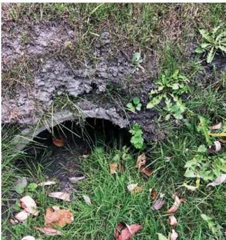
Érosion de la structure d'un ponceau
